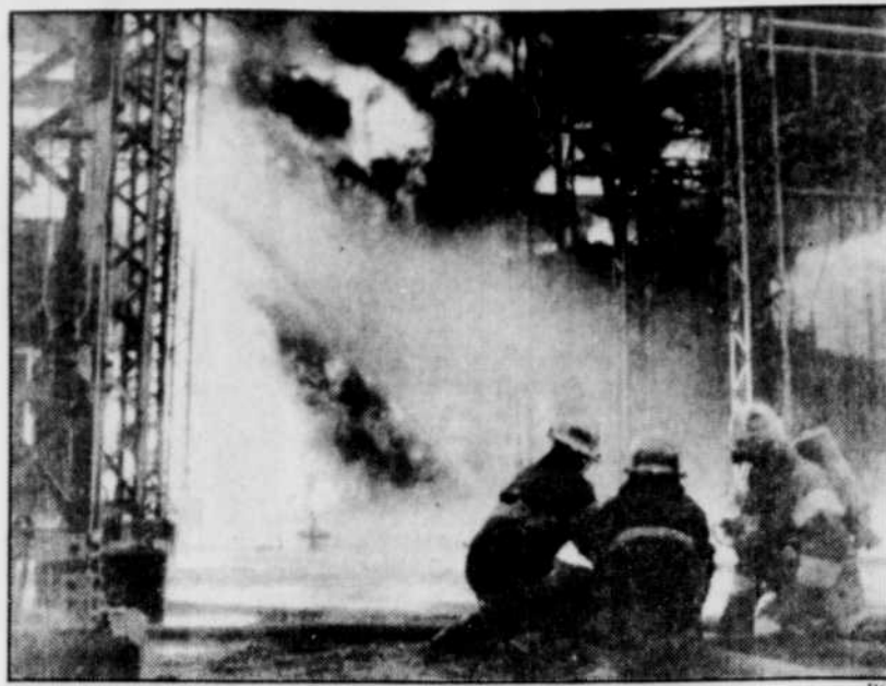
L'incendie de deux transformateurs d'Hydro-Québec, dans l'Est de Montréal jeudi soir, n'a fait aucun blessé.
