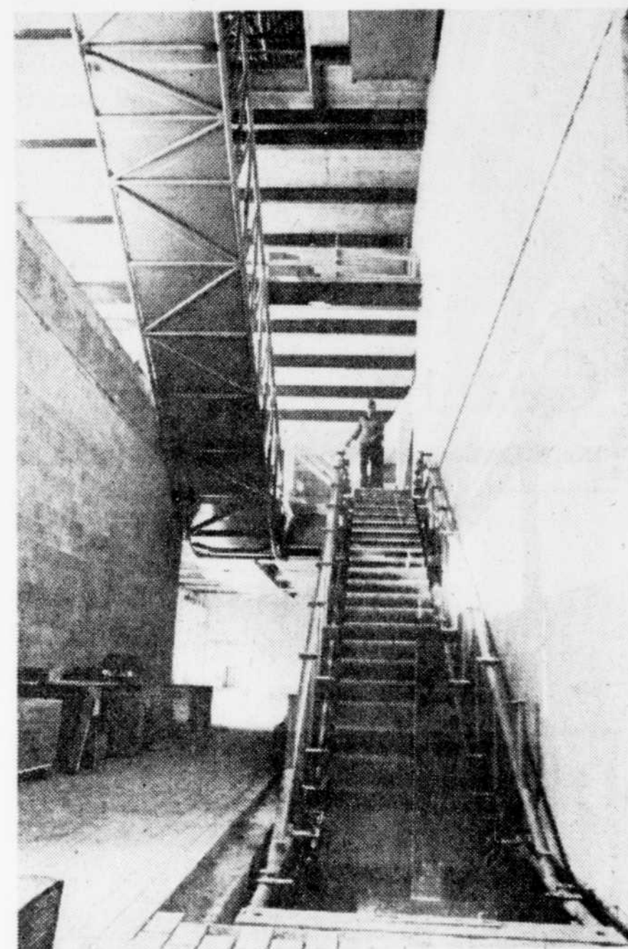
Les nouveaux escaliers roulants devraient être prêts à l'automne.
