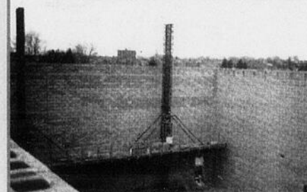
Les travaux d'agrandissement à l'école secondaire publique L'Héritage à Cornwall.
