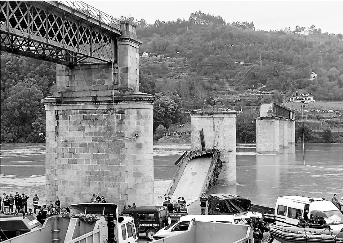
Les ponts s'effondrent aussi en Europe, comme ici, au Portugal en mars 2001, où 59 personnes sont mortes.
