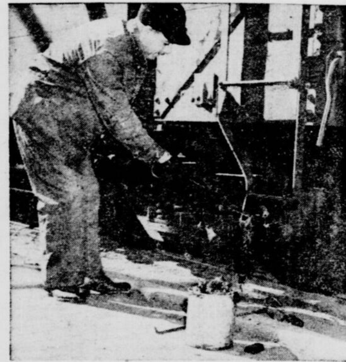
BOITE CHAUDE. — Il arrive encore qu'un essieu devienne tellement chaud par suite du frottement que le feu prend dans la graisse et les rebuts de coton de la boîte. C'est ce qu'on appelle une « boîte chaude ». Le train arrête alors et le serre-frein remplace les lubrifiants.
