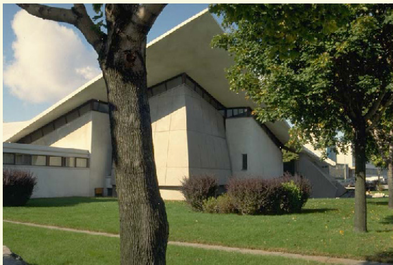
Église Saint-Gaétan, Montréal, 1966-1967 Architecte : Louis-J. Lapierre
