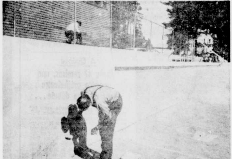
TOUCHE FINALE. — Des ouvriers sont à faire les derniers préparatifs avant l'ouverture officielle de la piscine de l'Académie. D'importants travaux de réfection ont été effectués cette année et on en est rendu à donner la touche finale qui consiste en une couche de peinture. Les jeunes pourront bientôt envahir la piscine pour la saison estivale. Sur la photo, on remarque un employé posant la peinture dans la piscine de l'Académie.
