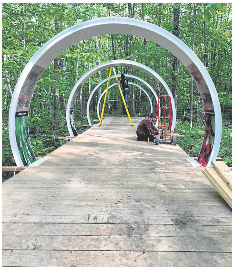
Les travaux vont bon train au Centre de la Biodiversité du Québec à Bécancour pour L'Écho des origines.
