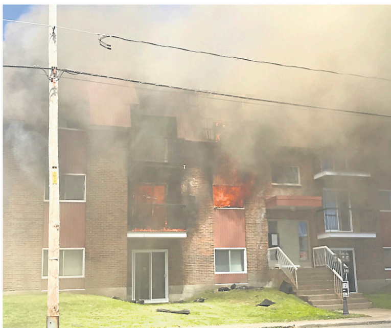
L'immeuble d'une douzaine de logements a été déclaré perte totale. — PHOTO: SYLVAIN MAYER
