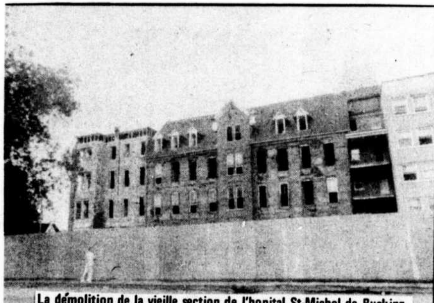
La démolition de la vieille section de l'hôpital St-Michel de Buckingham avance à grand pas, les hommes y travaillent tous les jours. Lorsque les travaux de démolition seront terminés ceux de la construction commenceront et la population en sera très fier.
