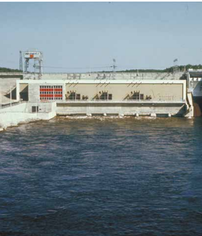
Façade de la centrale de la Première-Chute, date inconnue.
