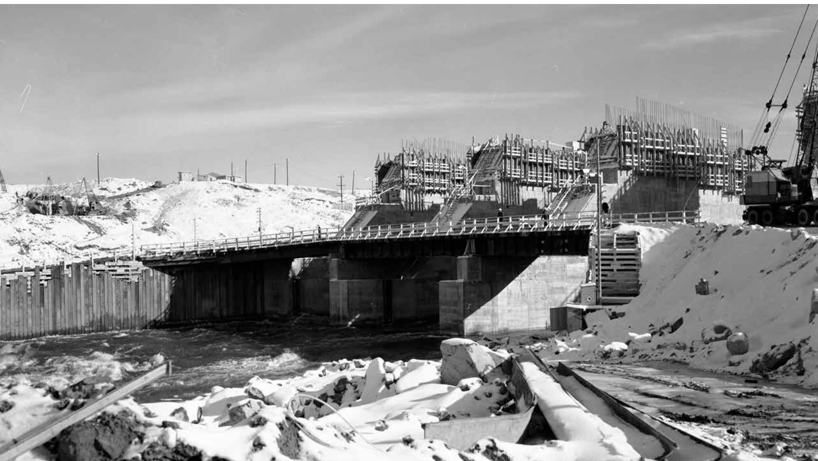
Vue du chantier de la centrale (1966).
