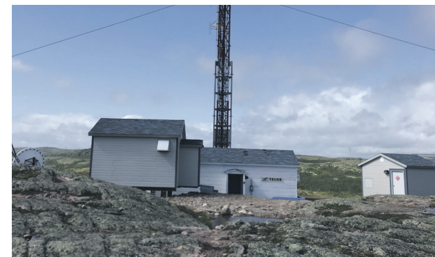
L'installation d'un câble sous-marin vise à créer une redondance du réseau à l'est de Baie-Comeau pour éviter les pannes d'Internet causées par le bris accidentel de la fibre optique. Photo courtoisie
