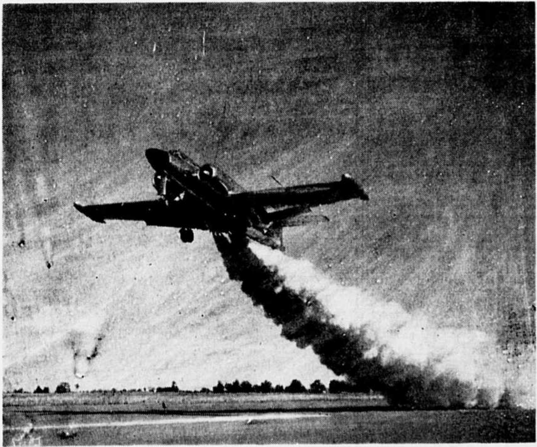
On voit ici le CF-100 Canuck, chasseur intercepteur à réaction à longue portée, au moment où il décolle avec l'aide d'un lanceur réactif à la station du C.A.R.C. d'Uplands où le C.A.R.C. éprouve cet avion nouveau genre. Le mécanisme de décollage à réaction est destiné à permettre aux avions lourds de prendre les airs sur des pistes d'atterrissage courtes. Dans l'épreuve photographiée ci-dessus, le CF-100 a décollé avec son plein d'essence, tout son armement et deux bombes de 1,000 livres chacune en moins de la moitié de la distance qu'il doit parcourir normalement avant que ses roues ne quittent le sol. Le CF-100 est dessiné et construit au Canada par la A. V. Roe (Canada) Limitée, de Toronto.
