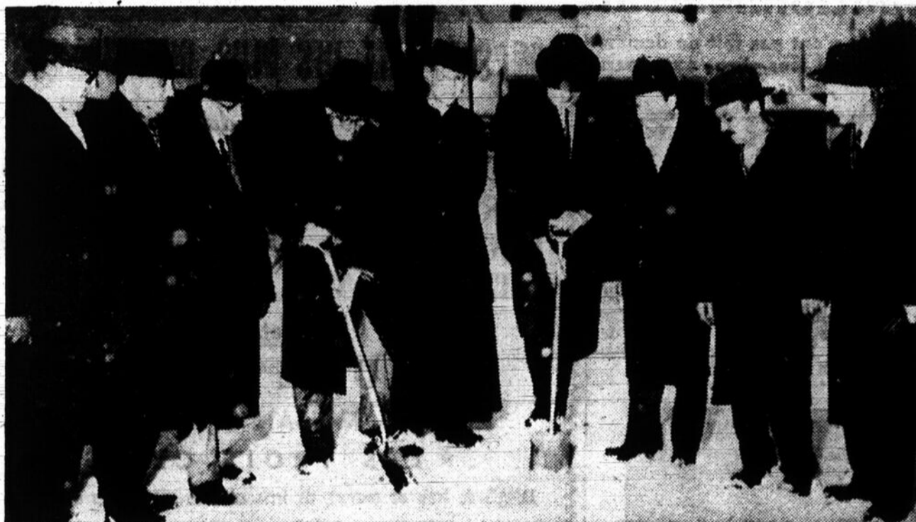
NOUVEAU CENTRE DOMICILIAIRE — On a levé la première pelle de terre symbolique, en fin de semaine, à l'endroit où sera construit un nouveau et vaste centre domiciliaire, à Pointe-St-Charles. Plusieurs personnages de marque ont assisté à la cérémonie. On remarquera, de gauche à droite, le conseiller Bruno Lépine, le conseiller A. Lecourt, M. Hervé Lajoie, représentant de la Société centrale d'hypothèque et de logement; M. le curé Robert Dubreuil, de la paroisse Saint-Jean; M. H. S. Lang, M. Frank Hanley, député de Ste-Anne à Québec; le conseiller Albert Collette et M. Edmond Hamelin. (Photo "Montréal-Matin" par David Bier)
