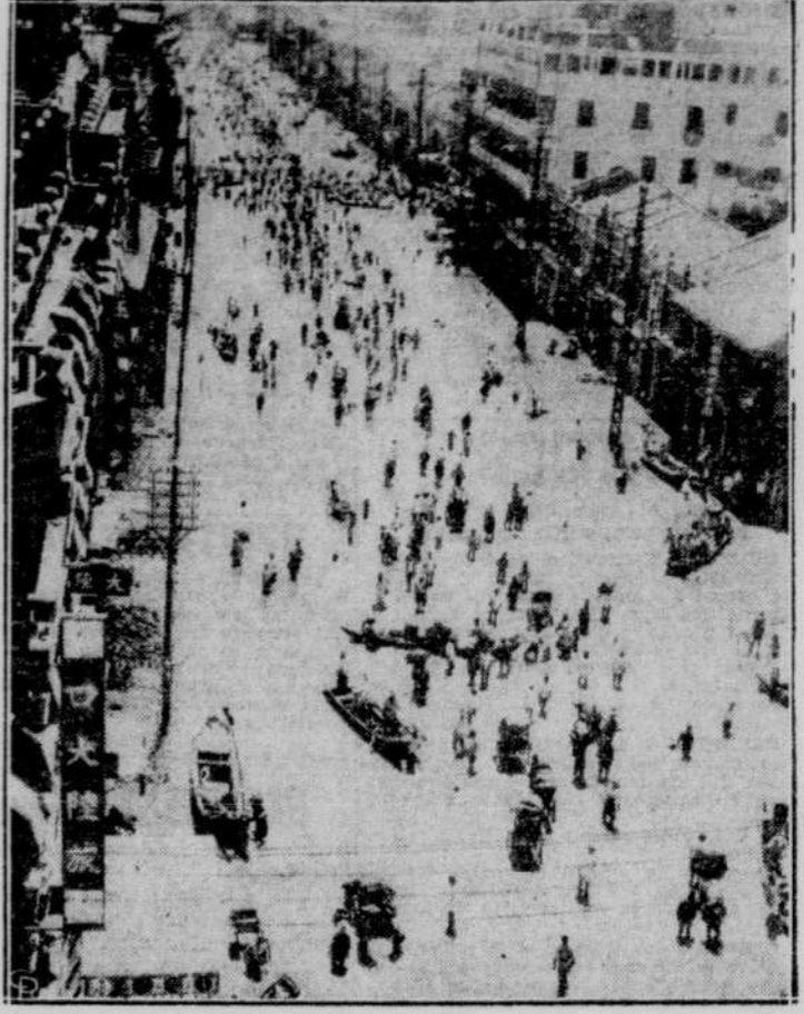
Voici l'aspect que présentait ces jours derniers la ville de Hankow, au Japon, qui fut inondée par la crue des eaux des fleuves Jaune et Yangtze. — Hankow était une des villes les plus riches du monde entier. Des milliers de ses citoyens sont morts de l'inondation tout récemment. Ajoutons que cette photo date de l'inondation de 1932 et non de cette année.
