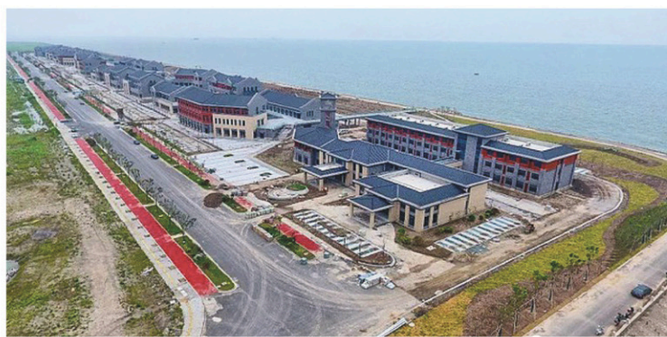
APÉRÇU DES TRAVAUX DE CONSTRUCTION DE LA PREMIÈRE PHASE. L'OUVERTURE EST PRÉVUE POUR JUIN PROCHAIN.
