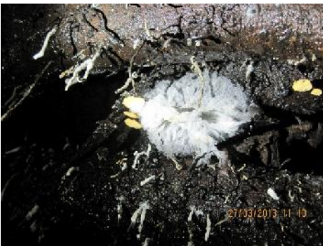
Quelques fructifications de champignons observées en 2013 sur les poutres des galeries souterraines d'une mine d'or à Taiwan.
