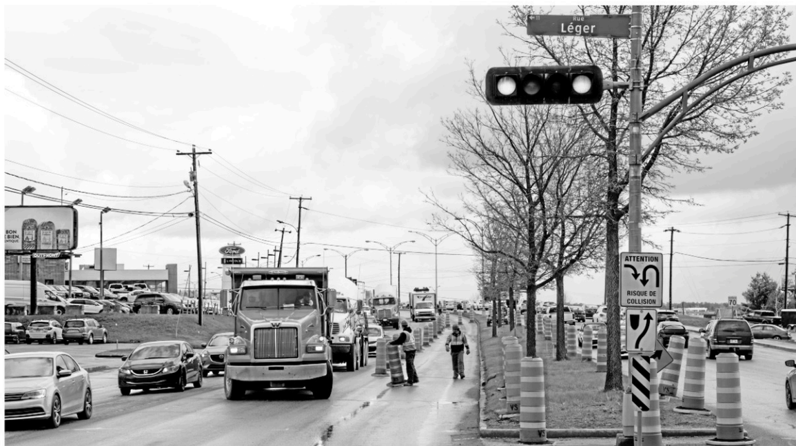
Les travaux devraient se poursuivre à l'intersection des rues Bertrand-Fabi et King Ouest jusqu'au 19 juillet. — PHOTO SPECTRE MÉDIA, MICHELLE BOULAY
