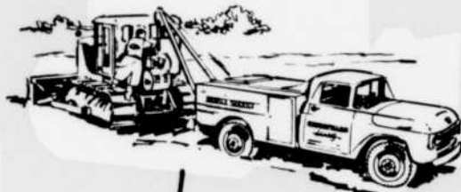
RÉPARATION SUR CHANTIER
