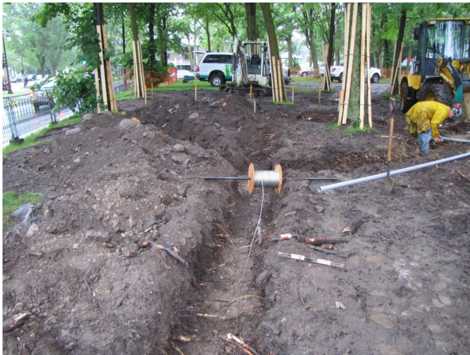
Figure 1 Vue des tranchées au parc du Sacré-Cœur, CfEt-7. En direction ouest, photo Serge Rouleau, A13-06-29.
