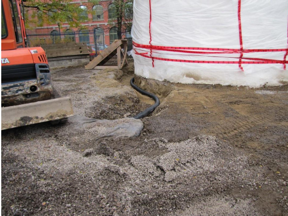
Figure 3. Vue du drain agricole près du moulin à vent, CeEt-884. En direction nord, photo Serge Rouleau, A13-10-01.
