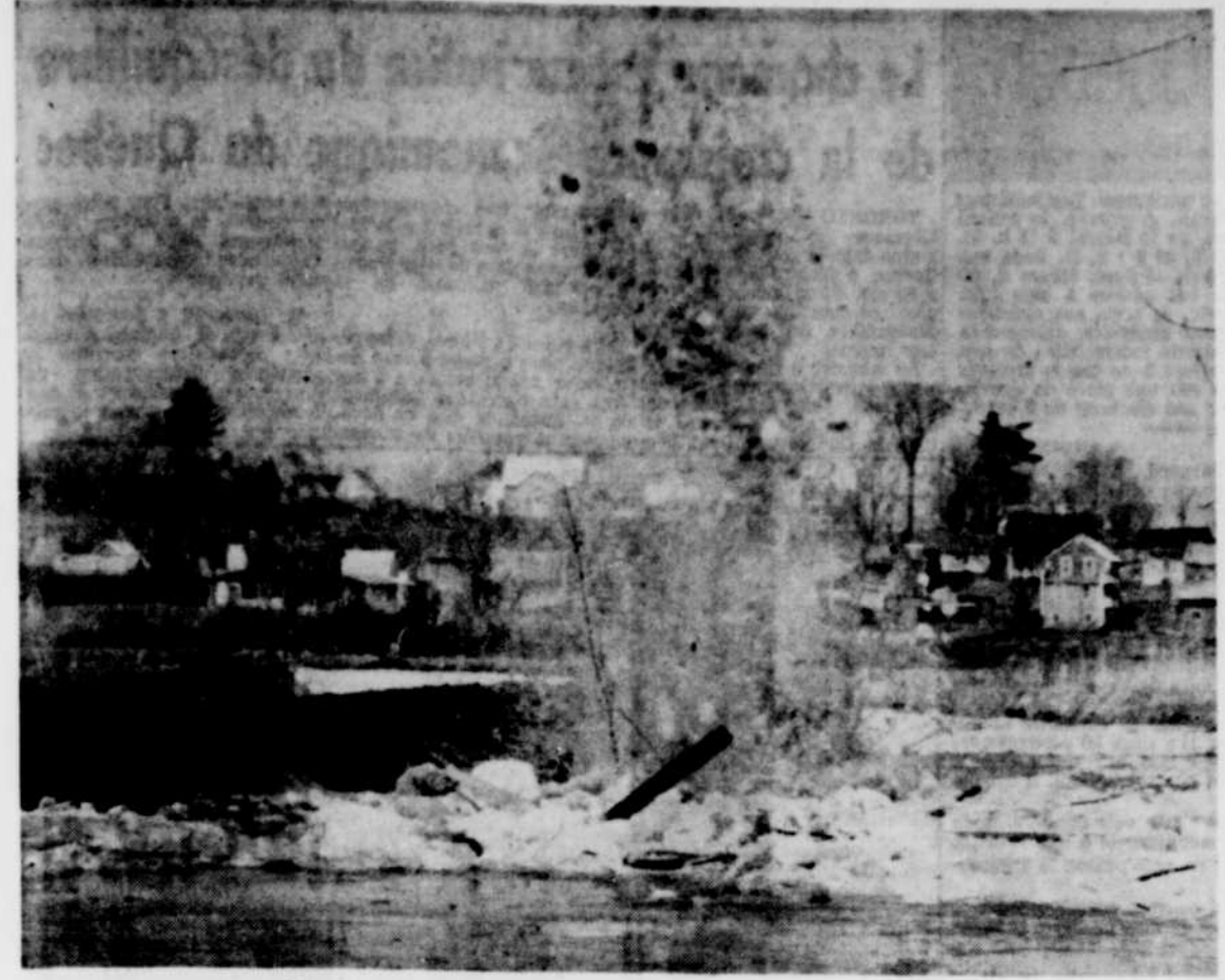
A l'aide de dynamite, on tente de prévenir les embâcles sur la rivière. (Photo Ross, Coaticook)
