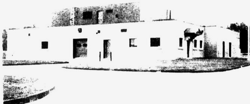
Aussitôt prête, aussitôt en opération. Le ministère de l'Environnement n'a pas attendu quelque règlement politique pour faire démarrer les opérations de la station d'épuration des eaux usées. (Photo l'Écho)
