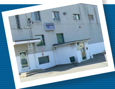
Le vieux centre sportif est tombé sous le pic des démolisseurs en octobre et novembre dernier.
