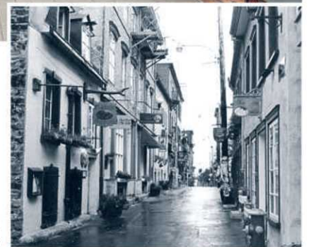
Quartier Petit Champlain, avant la restauration
