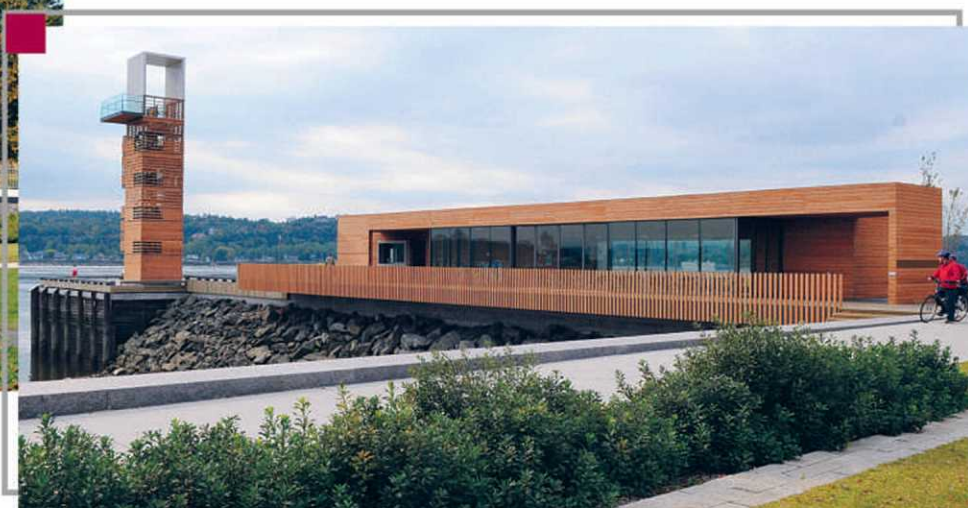
Bâtiment d'accueil et tour d'observatoire du Quai des Cageux
