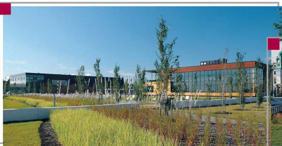
Bâtiments de services pour parc Récréo Nautique de la Baie de Beauport
