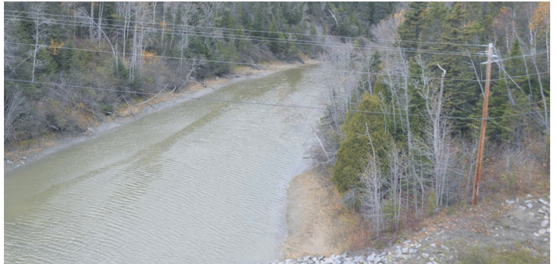
Baie-Sainte-Catherine s'expose à de fortes amendes si elle n'a pas résolu son problème de traitement des eaux usées d'ici 2020.
