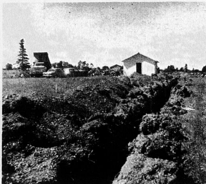
Au début de la semaine on s'affairait à installer les équipements nécessaires sur un terrain de camping. (G.Q.- LE PEUPLE)
