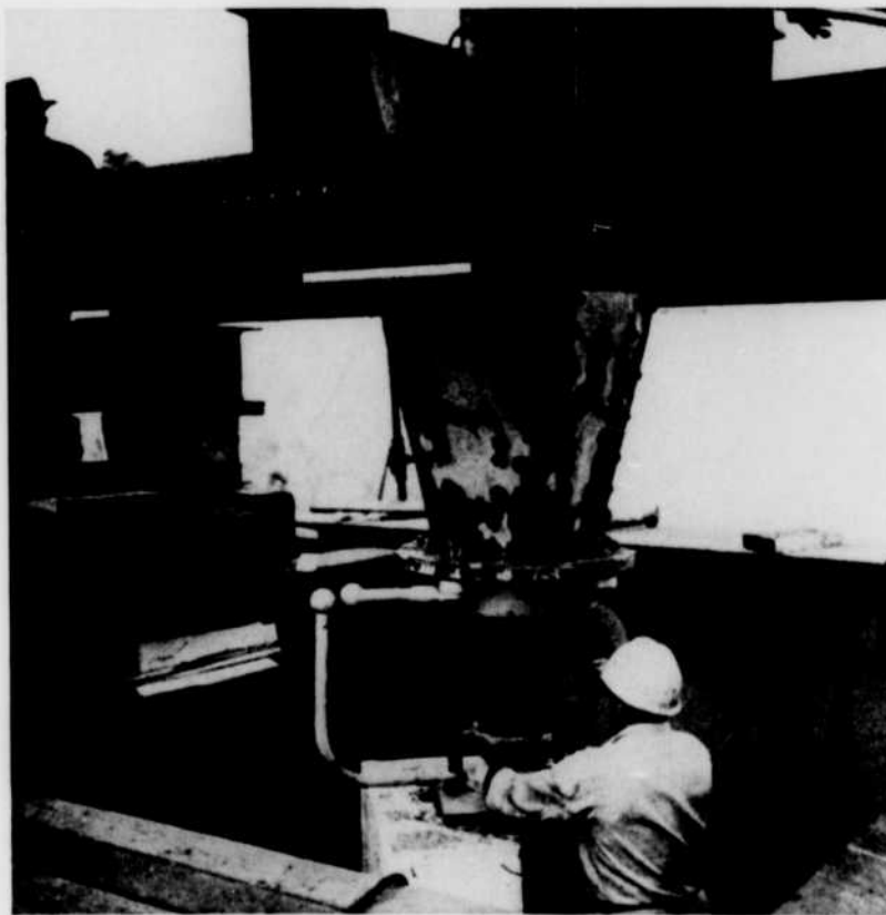
Notre illustration représente la base de la tour qui sert d'antenne au poste CBF à Verchères. Lundi, 5 septembre, les émissions de CBF furent interrompues quelque temps le matin afin de permettre les réparations qui devaient être effectuées à la base de l'antenne : un ouvrier est ici à remplacer l'isolateur de porcelaine dans lequel on avait découvert une fissure.
