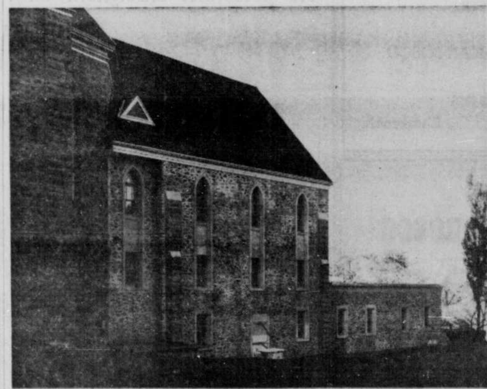
L'ABSIDE DE LA PAROISSE ST-PATRICE. — Voici une autre vue de l'abside de la paroisse St-Patrice. Photographiée du côté nord, une porte donne accès sur les courts de tennis.
