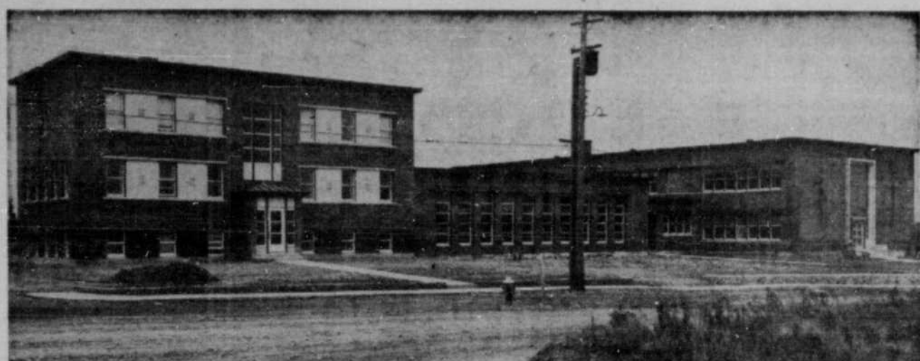
LE COUVENT SAINT-JEAN-BOSCO DE MAGOG. — 350 élèves fréquentent le nouveau Couvent Saint-Jean-Bosco que la Commission scolaire catholique de Magog a fait ériger au coût de $289,500. Cette photo nous montre, à gauche, la bâtisse de trois planchers qui loge le personnel religieux, et à droite, la nouvelle maison d'éducation, avec au centre la salle de récréation.
