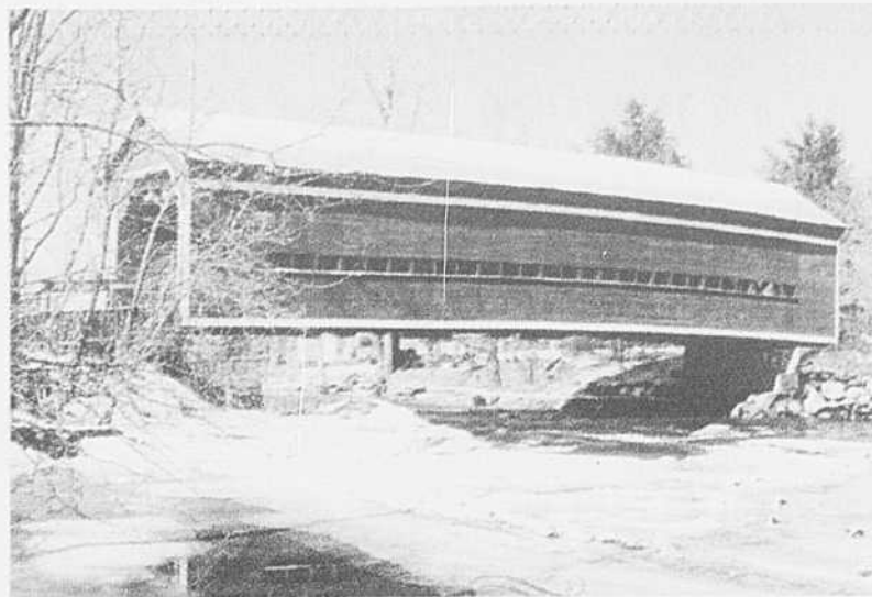
Le pont Balthazar, à Brigham
