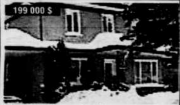
199 000 $ LA BAIE: 2302, 8 e Avenue. Tout brique avec abri d'auto, terrain clôturé avec vue sur la Baie. 4 ch. à l'étage avec une salle de bains complète, salle à manger et salon avec foyer, coin repas dans la cuisine et TOUT RÉNOVÉ.
