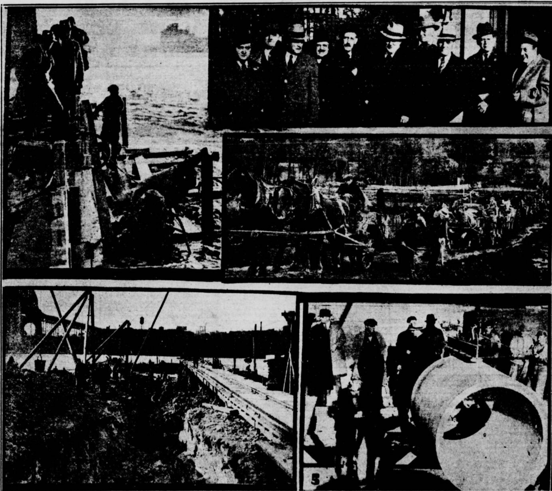
Un groupe de personnages officiels et de journalistes accompagnait hier M. André d'Astous dans une visite des travaux que fait actuellement exécuter le gouvernement provincial sous la direction de l'hon. William Tremblay, ministre du Travail. (1) Le scaphandrier de la Compagnie de Construction Dufresne descend dans le Saint-Laurent pour travailler à l'érection d'une digue qui permettra d'installer les tuyaux d'égout collecteur de l'île Sainte-Hélène. (2) Le groupe, qui fait l'inspection, photographié lors de la visite des travaux au Parc Morgan. On remarque MM. Jos. Lavergne, L.-J. Ouellette, Maurice Dubrue, W.-T. Hann, Honoré Meunier, André d'Astous, Henri Saint-Pierre, F. Wright, F.-T. Todd et Maurice Huot. (3) Les chevaux à l'oeuvre dans la construction du lac artificiel Castor, sur la Montagne. (4) Travaux de construction du canal d'égout sur l'île Ronde. (5) La pose d'un tuyau de 4 pieds de diamètre pour l'égout collecteur des îles Ronde et Sainte-Hélène. (Photos la "Patrie").
