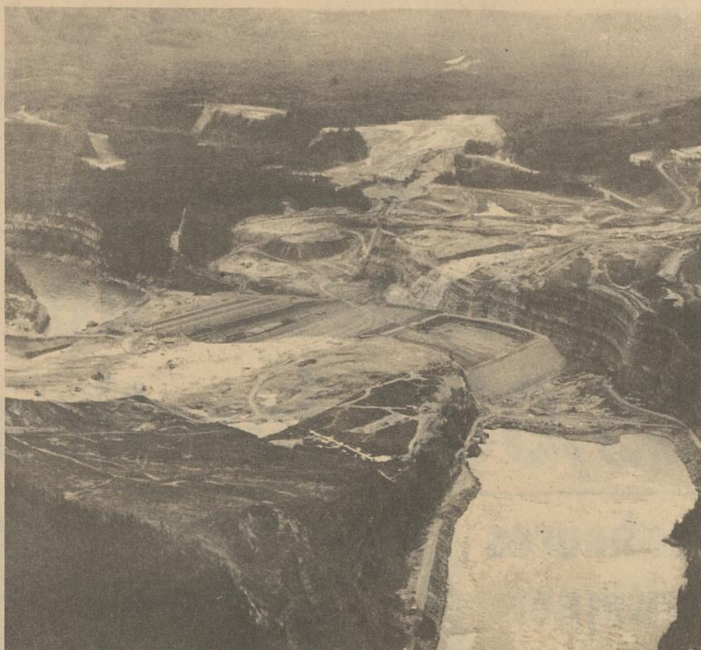
Les eaux de la Rivière à la Paix s'engouffrent actuellement dans un canal aménagé sous la terre pour permettre la construction du barrage de l'Hydro de la Colombie britannique. Ce barrage que l'on voit au centre de la photo aura une hauteur de six cents pieds, une fois terminé. Sa hauteur actuelle est de cent cinquante pieds.
