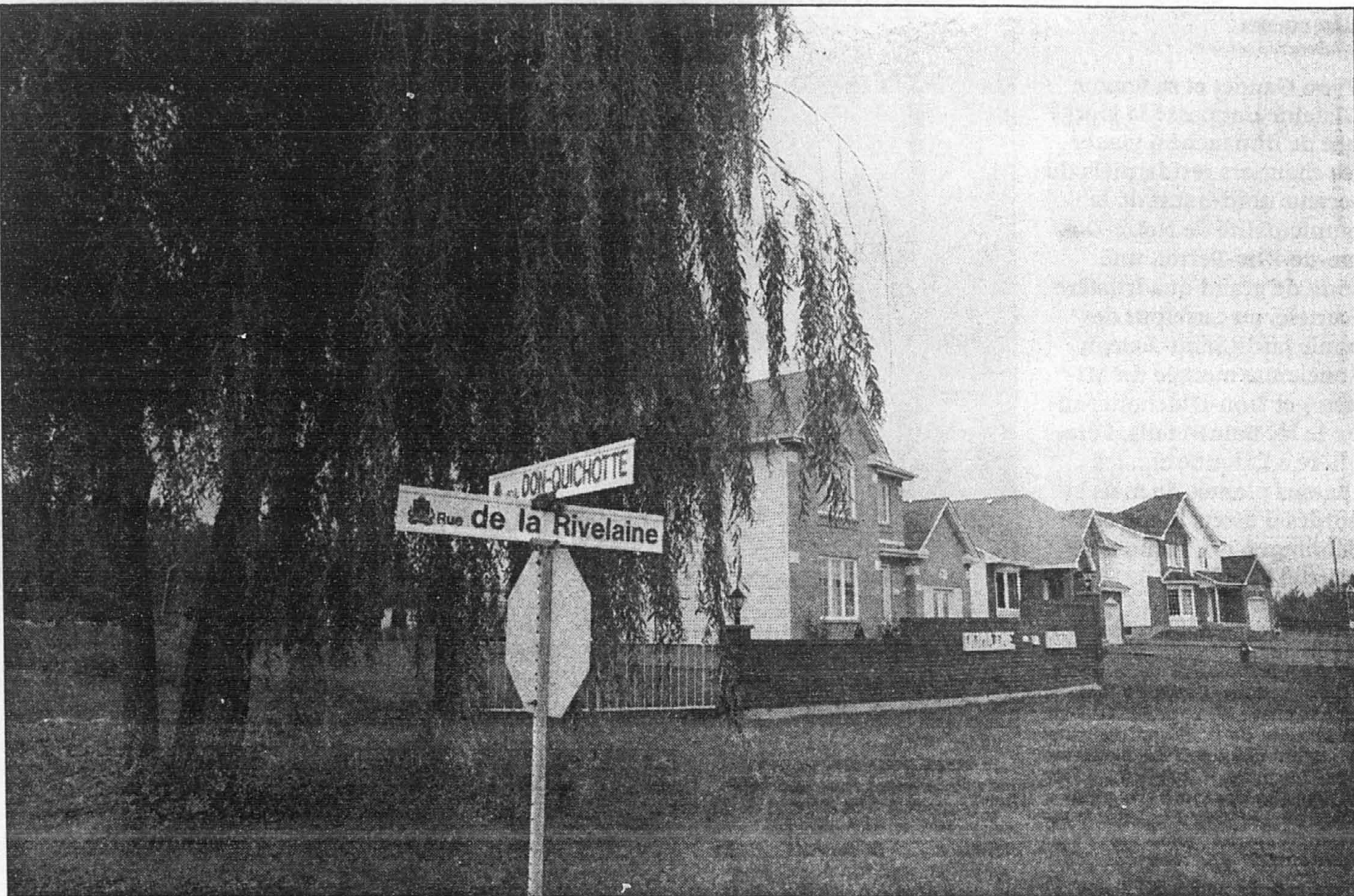
Le projet du Domaine de la Marina est entré dans sa dernière phase.
