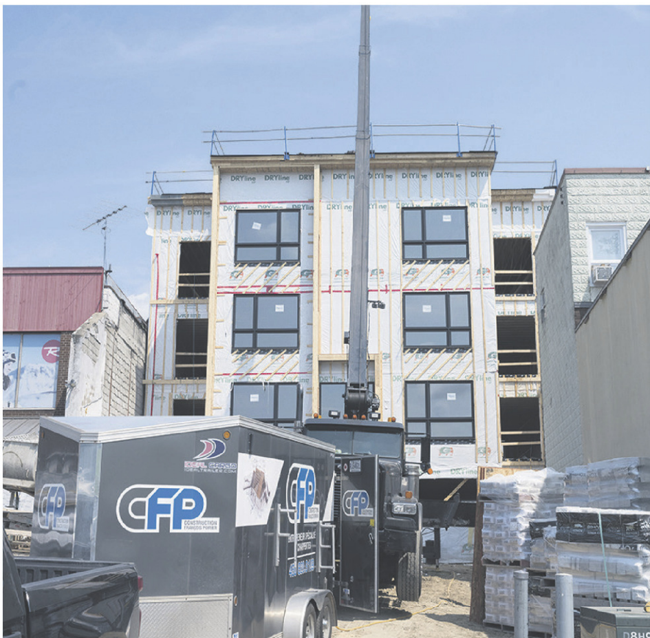
Alors qu'une part importante de la rue St-Vincent de jadis disparaît, un nouveau bâtiment, situé à l'adresse civique 68, sort quant à lui de terre. (Photo L'info du Nord - André Chevrier)
