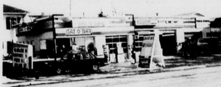
Gaz-o-Bar, une station service localisée à l'intersection des rues Rouleau et St-Germain.
