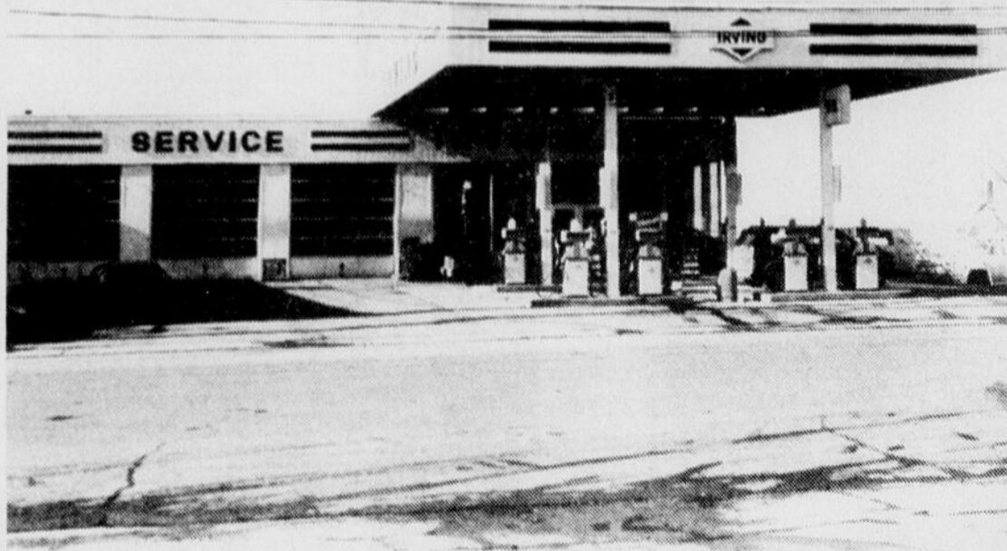
Service Carol Roy, une entreprise digne de confiance sise sur St-Germain ouest.
