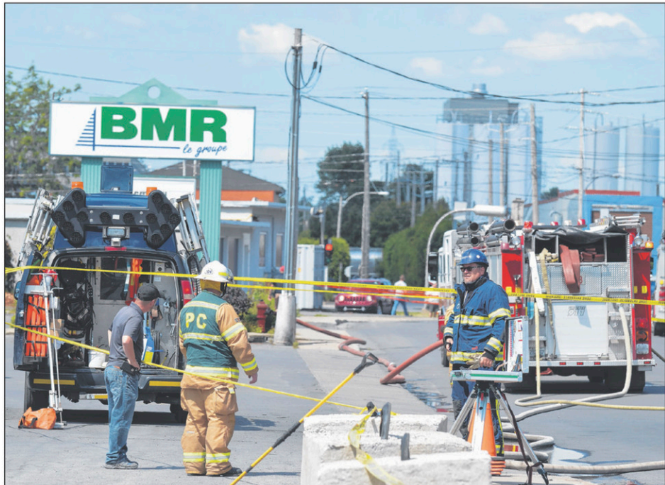
La fuite de gaz s'est produite entre le 201 et le 205, rue Saint-Joseph.
