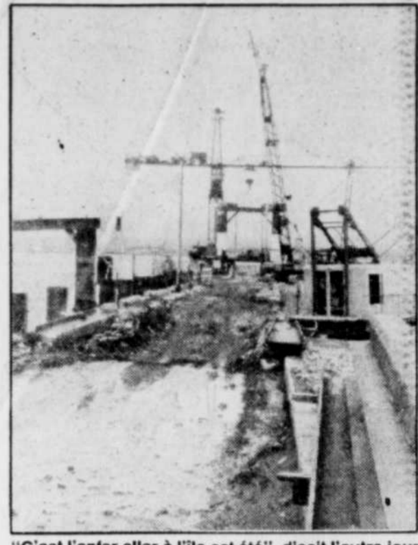
"C'est l'enfer aller à l'île cet été", disait l'autre jour un passager sur le Grue-des-Îles. A cause des travaux au quai, l'embarquement et le débarquement se font par cette route défoncée.
