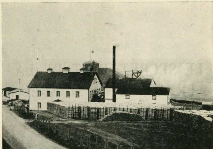
Un centre de l'industrie de la pêche, usine de sous-produits et entrepôt frigorifique.
