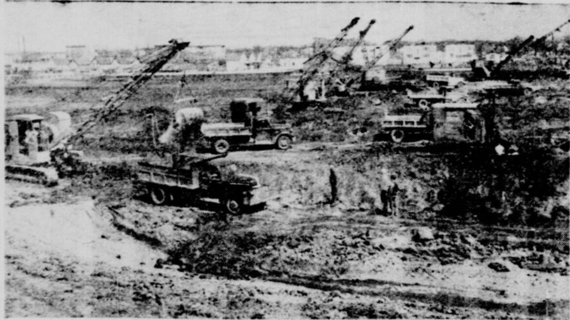
On voit ici huit pelles mécaniques géantes chargeant des camions avec de la terre, ensuite mise dans des
