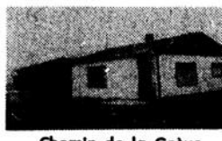
Chemin de la Grève Grosses-Roches
