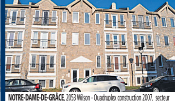
NOTRE-DAME-DE-GRÂCE , 2053 Wilson - Quadruplex construction 2007, secteur très achalandé, près du métro Vendôme, Université de Montréal et services, chauffage électrique payé par locataires, 2 stat. ext., 889 000 $. S. Gabriel 514 731-7575
