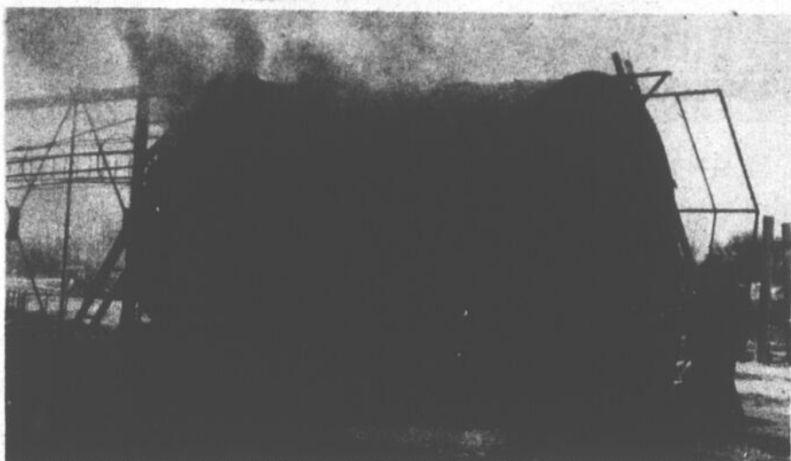
A l'arrivée des pompiers, une fumée dense sortait du silo.
