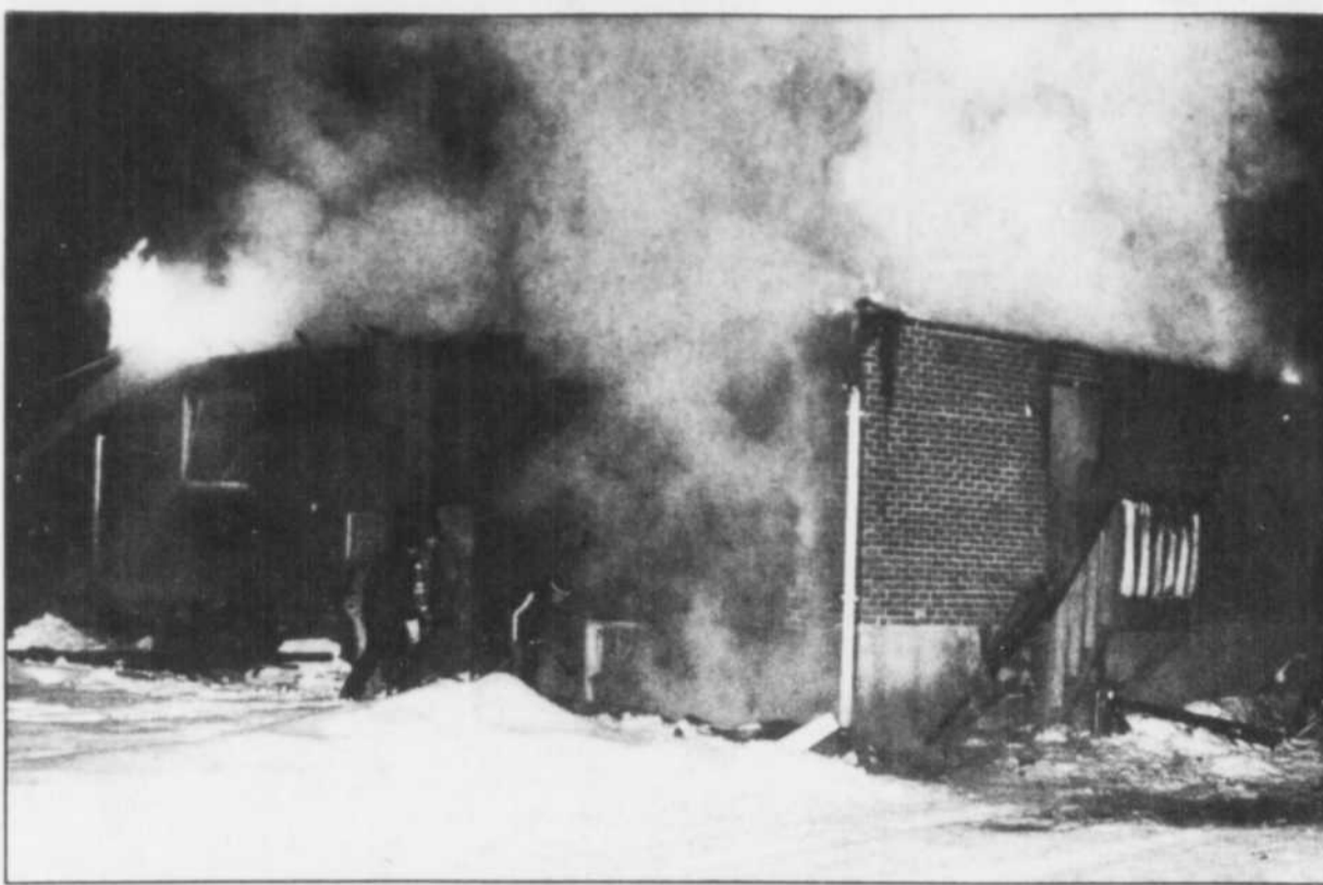
Les flammes ont lourdement endommagé les deux logements d'une maison d'habitation de la Rue Richard à Saint-Gérard-des-Laurentides. (Photibo Claude Gill)
