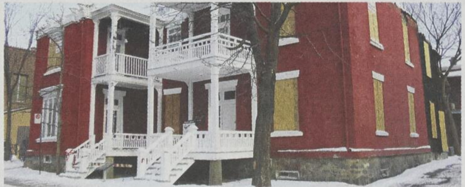
Le Parti québécois se range du côté des experts qui estiment que la maison Dessaulles doit être restaurée. Photo Patrick Roger | Le Courrier ©
