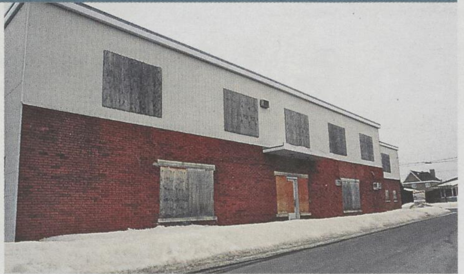
Propriété depuis peu de la Ville de Saint-Pie, le bâtiment de l'ancienne usine Stylebois sera prochainement démolé. Photo Robert Gosselin | Le Courrier ©
