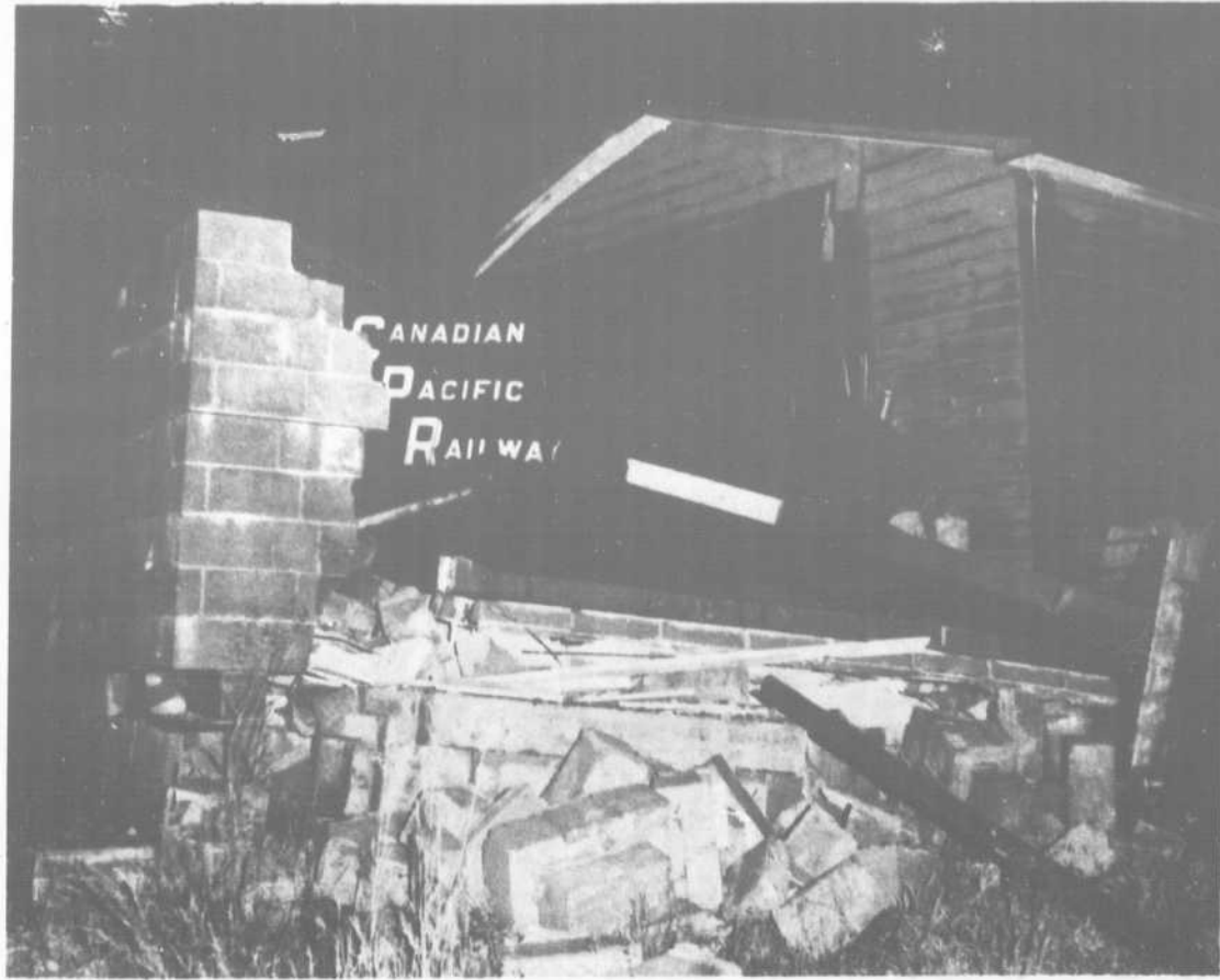
UN DES WAGONS DE MARCHANDISES a pénétré sous la force de l'impact à l'extrémité nord de la gare, enfonçant un mur de blocs de ciment et la structure en bois.
