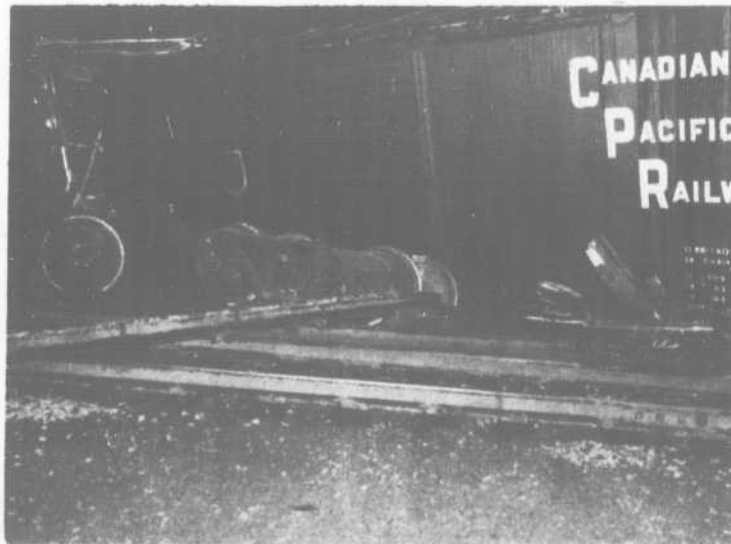
DES RAILS ARRACHES, des roues de wagon détachées, des morceaux de débris, jonchent les voies du P.C. à Terrebonne depuis jeudi dernier.
