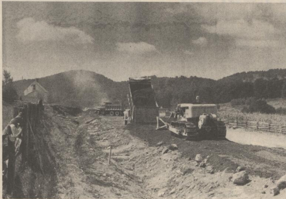
Des travaux sont présentement en cours à Cowansville, sur le Grand Boulevard nord, projetés pour aller rejoindre la voie d'accès à l'autoroute, à la hauteur de la sortie 37. La machinerie lourde est en mouvement...
