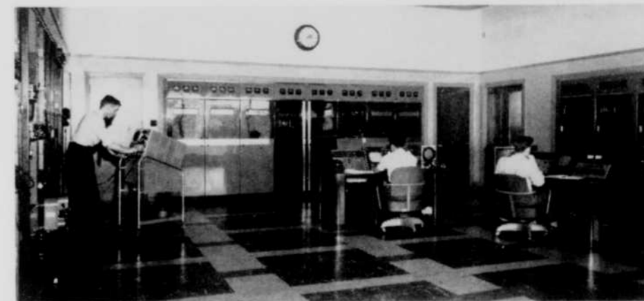
La salle de régie des émetteurs de Radio-Canada sur le Mont-Royal . . . A gauche, un technicien vérifie le niveau des signaux électriques alors que deux de ses camarades sont à leur poste aux consoles de CBFT et CBMT, surveillant la qualité de la diffusion.
