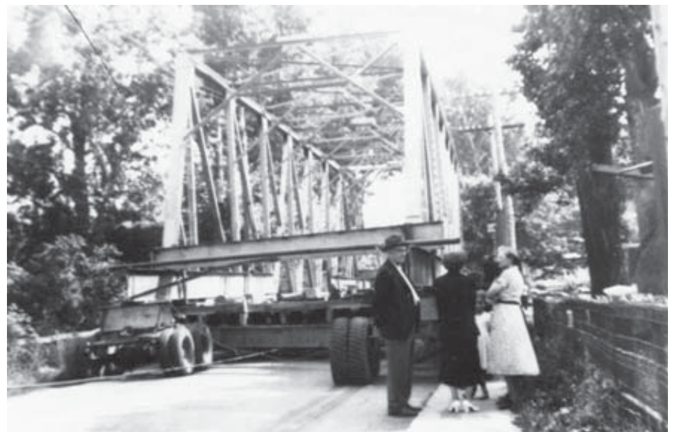
Pont métallique à Saint-Pacôme. Crédit : Archives de la Côte-du-Sud et du collège de Sainte-Anne.
