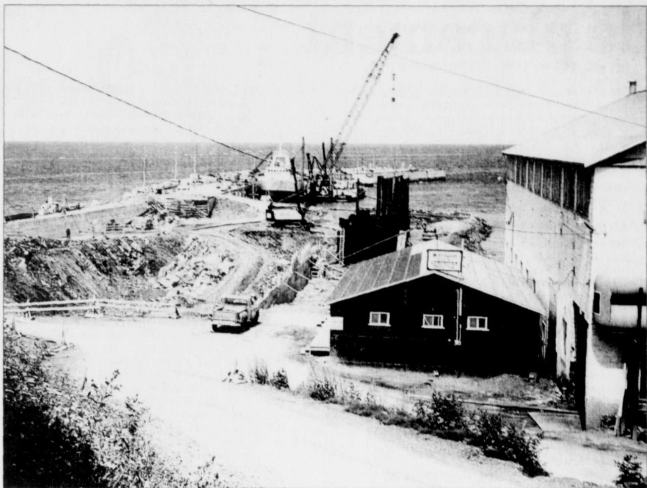
En 1970, le chantier naval avait des airs beaucoup plus modestes qu'aujourd'hui.
