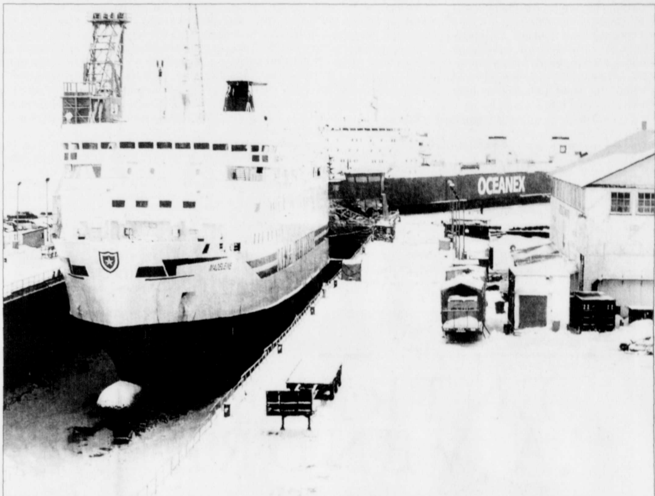
La même portion du chantier photographiée cette semaine.
