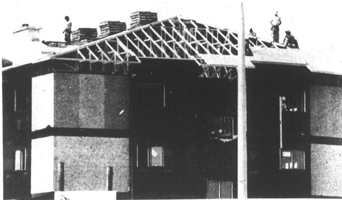
Depuis le début de l'année, l'industrie de la construction a subi un ralentissement important à Iberville. (photo Archives)
