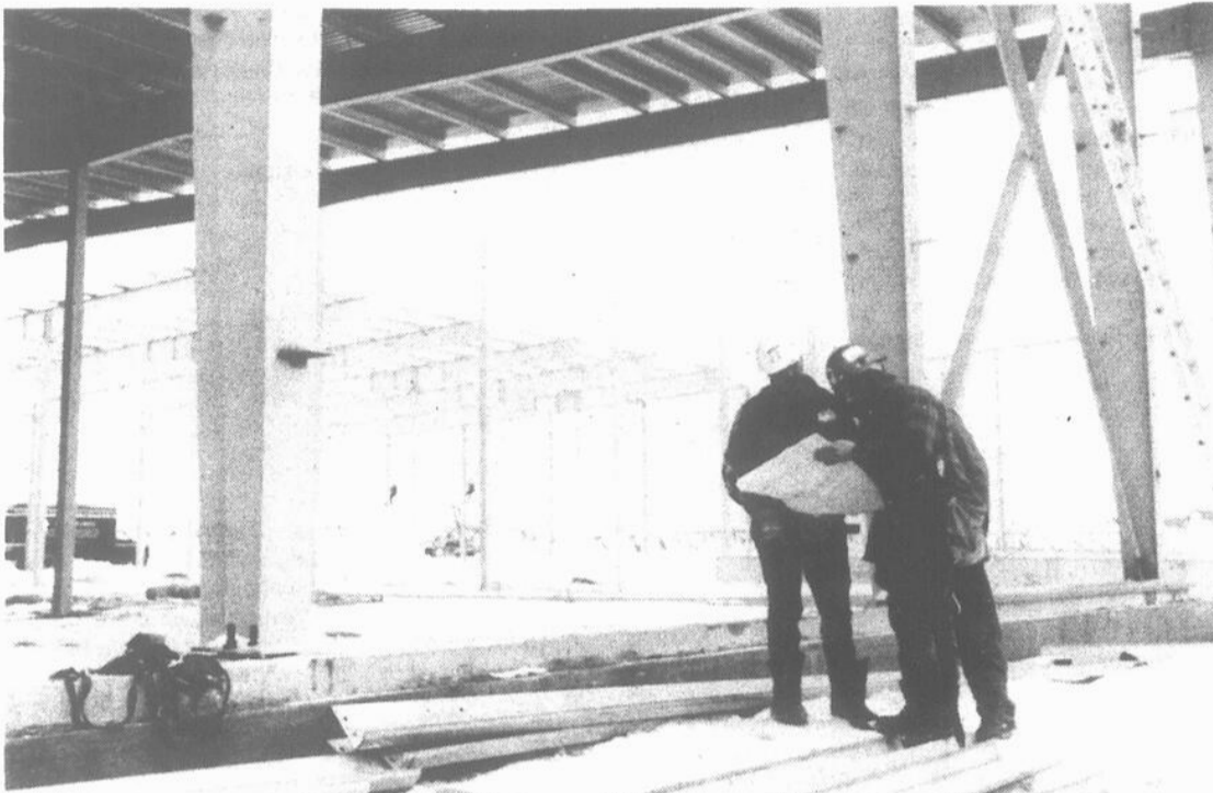
Il faut beaucoup de communication et de coordination pour construire un pareil bâtiment. (photo l'Écho - Yves Bellefleur)
